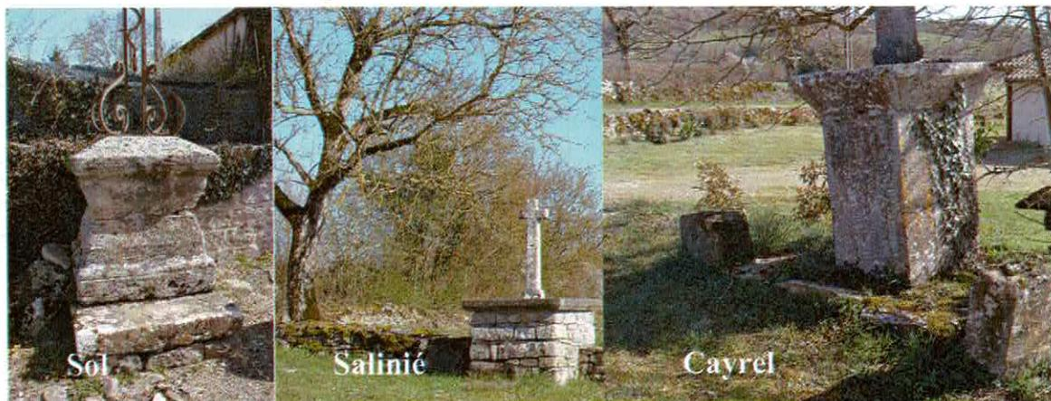
Les travaux devraient se réaliser au cours du premier trimestre 2020. Il s'agit de nettoyage sablage, de consolidation et de rejointoiement.
